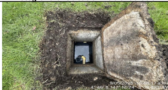
Fotografía 9. Tubería de distribución al campo de infiltración.
