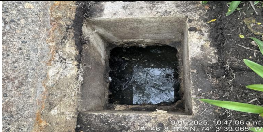
Fotografía 6. Caja de paso. Recepción de las ARD del conjunto.
